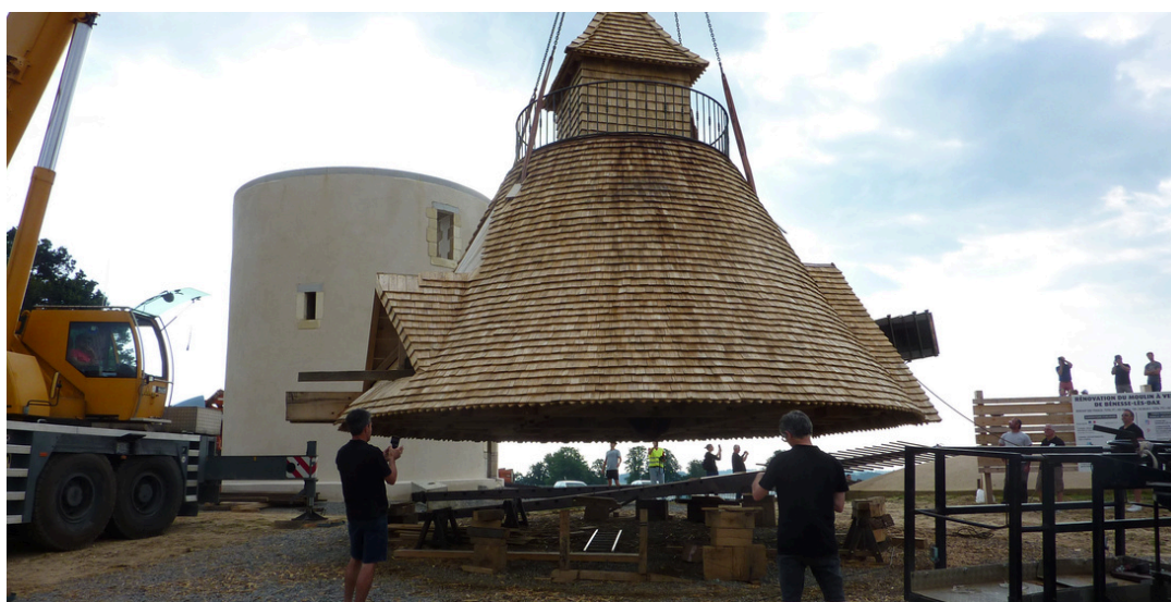
Pose du toit
